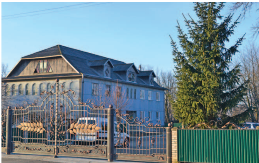
Админздание АЧАП «Золотой колос», с. Строинцы.
